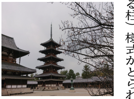
五重塔。西院伽藍にある金堂、中門、回廊とともに現存する最古の木造建築。
