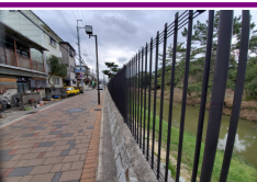
地図⑦地点。左は民家、右は大仙古墳の外壕
