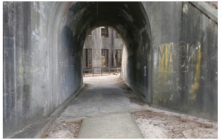
奥の奥に発電所跡があります。ここからトンネルが通っています。うさぎの足音が集まっています。
